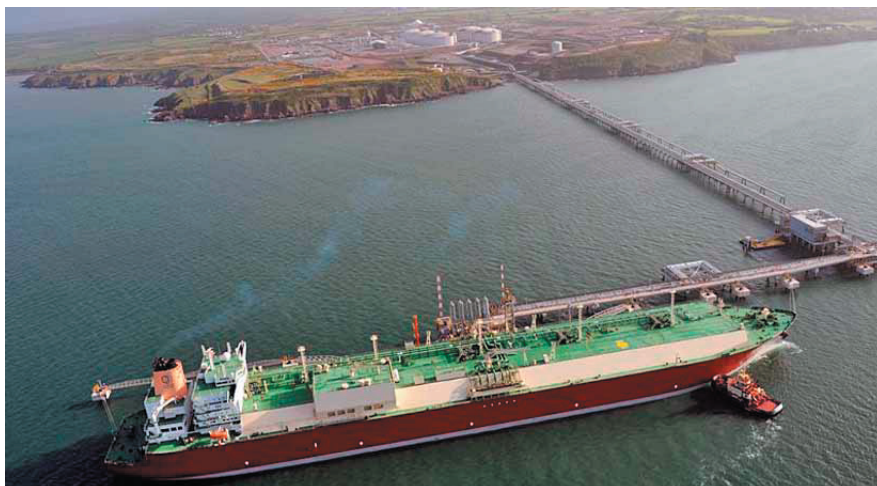
The South Hook LNG terminal and jetty
